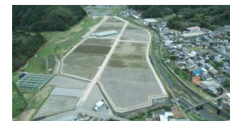
【志和地区(四万十町) ほ場整備】
