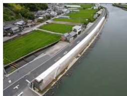
【下田川】 (河川堤防の耐震対策)
