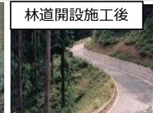
林道開設施工後
