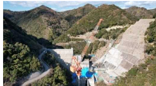
和食ダム建設
