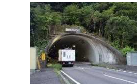
国道441号 網代トンネルの点検状況
