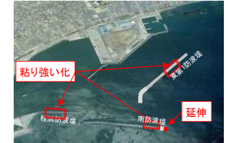
高知港防波堤の整備
