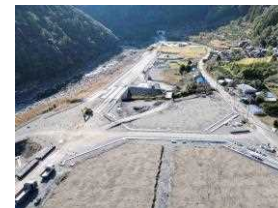
国道493号 (北川道路2-2工区)
